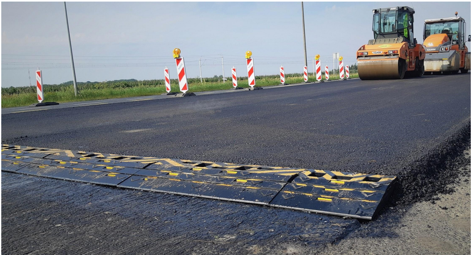
Belka ReBe podczas testów na placu budowy. Fot. KPMP
